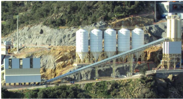
Sistema de trasiego y transporte neumático fase densa para cemento, filer y ceniza.
