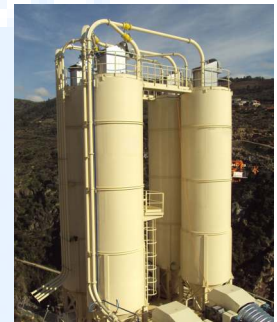
Transporte neumático cemento y ceniza para varios destinos. Suministro continuo a planta.
