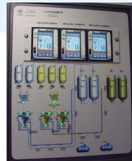
Automatismo para control proceso de mezclado y transporte neumático fase densa. Carga a silos de producto terminado.
